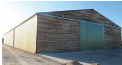
Bardage extérieur en peuplier modifié thermiquement, Brie (80)
