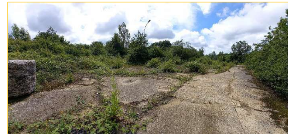
15) Vue de la plateforme bétonnée au sud de l'aire d'étude
