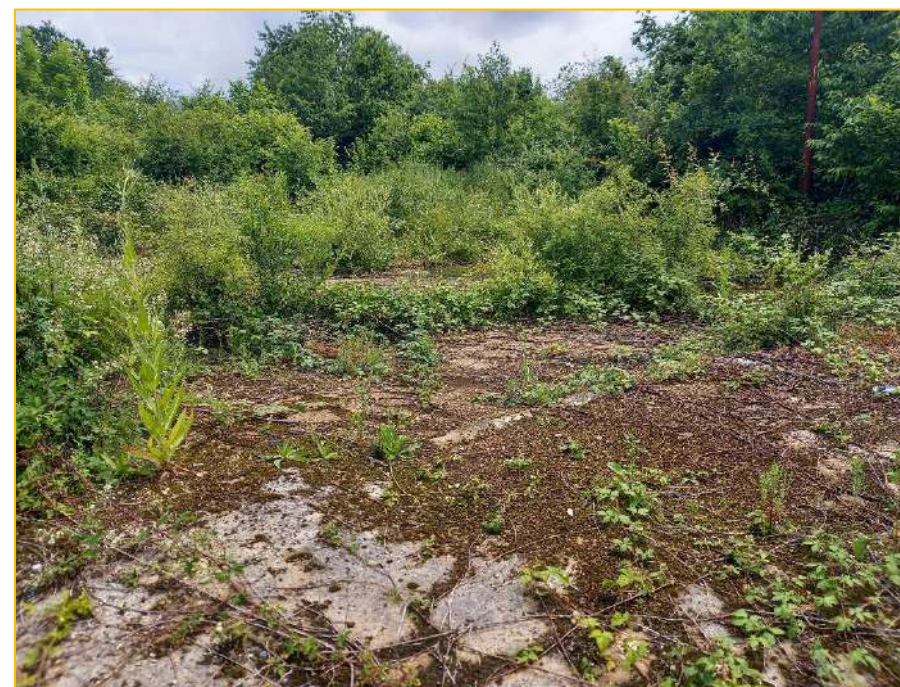
Figure 68 : Sols encore bétonnés présents au sud du site
