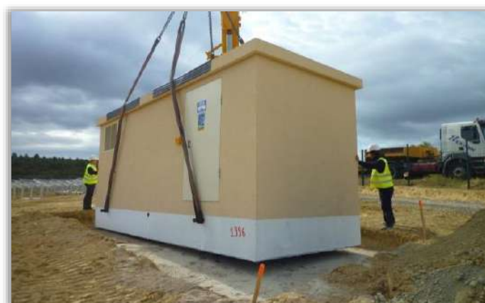
Figure 29 : Schéma de dépose des postes préfabriqués - Source : Transfix
