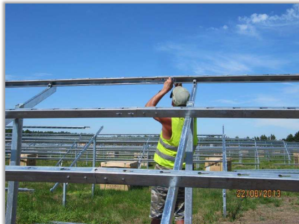
Figure 9 : Systèmes de fixation pour installation photovoltaïque
