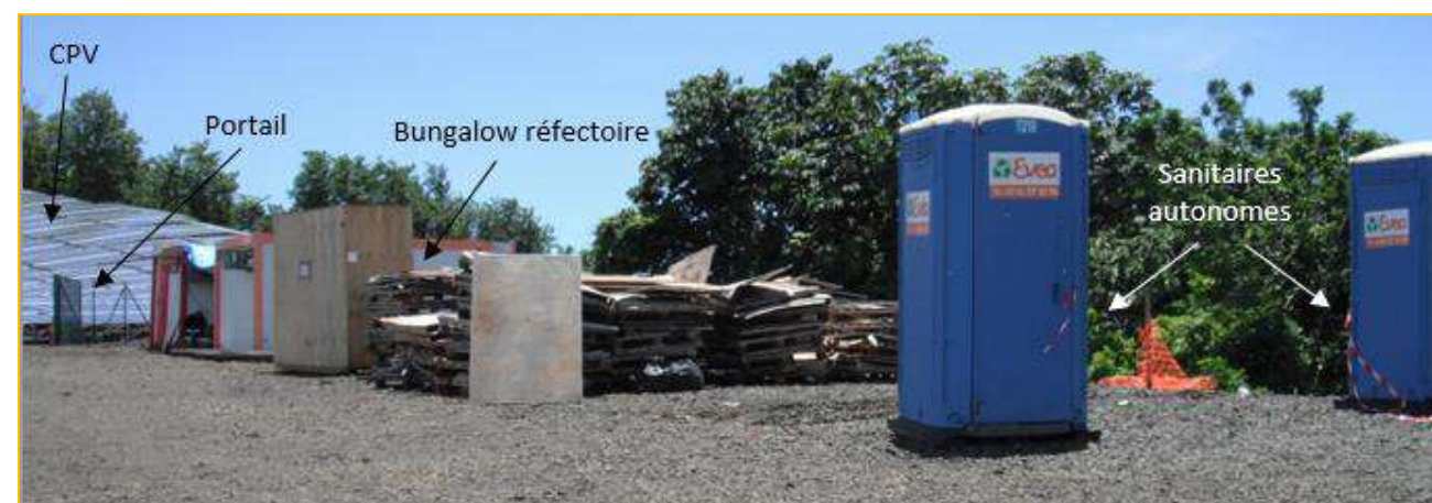
Figure 95 : Organisation base de vie d'un chantier de CPV
