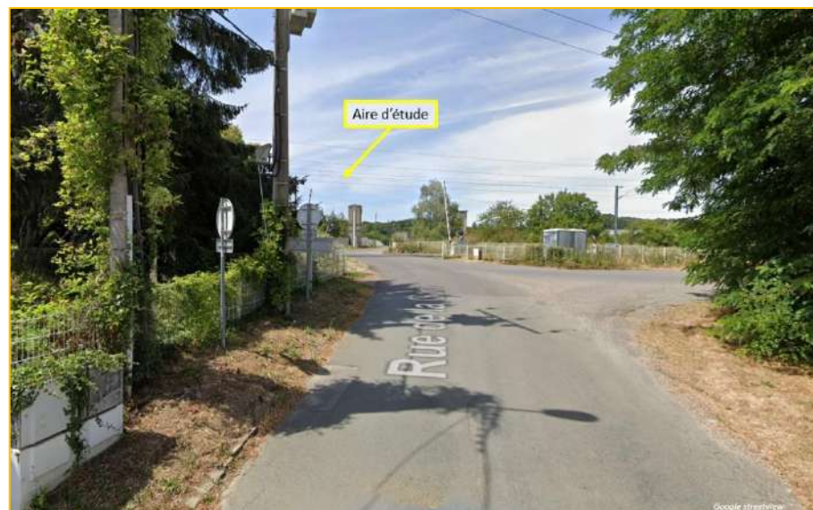
Figure 109 : Vue depuis la rue de la gare après le passage de la voie ferrée
