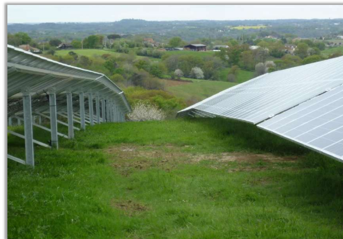
Figure 10 : Adaptation des tables à la topographie
