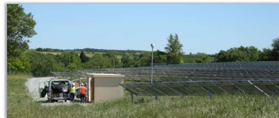
Figure 33 : Opération de maintenance
