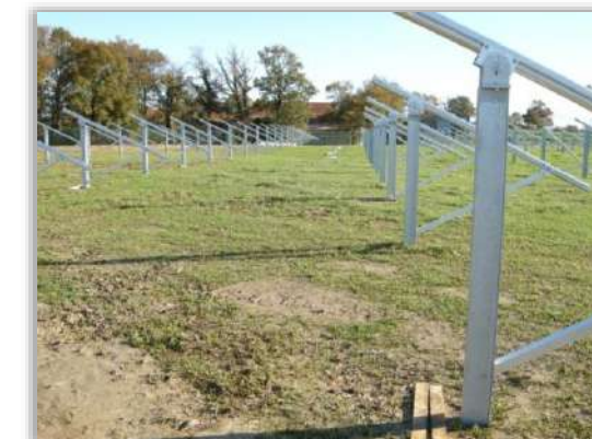
Figure 27 : Structures prêtes à recevoir des modules
