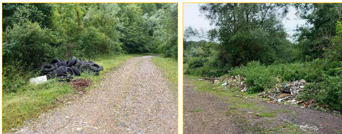
Figure 96 : Dépôts sauvages de déchets sur site
