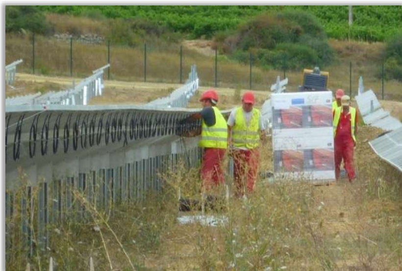
Figure 17 : Câblage et interconnexion des modules photovoltaïques
