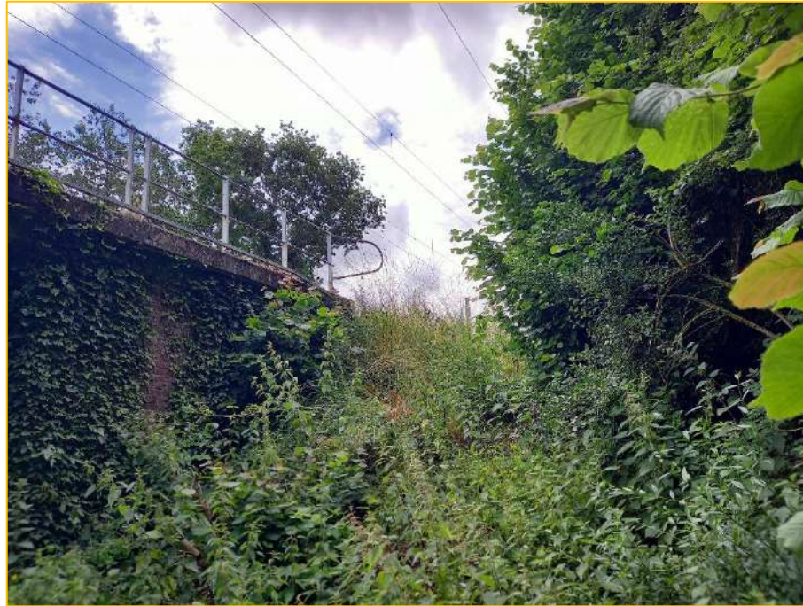
16) Vue de la voie ferrée depuis le chemin qui borde l'aire d'étude au sud-est
