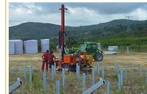
Figure 74 : Batteuse de pieux
