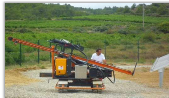
Figure 26 : Machine de battage des pieux
