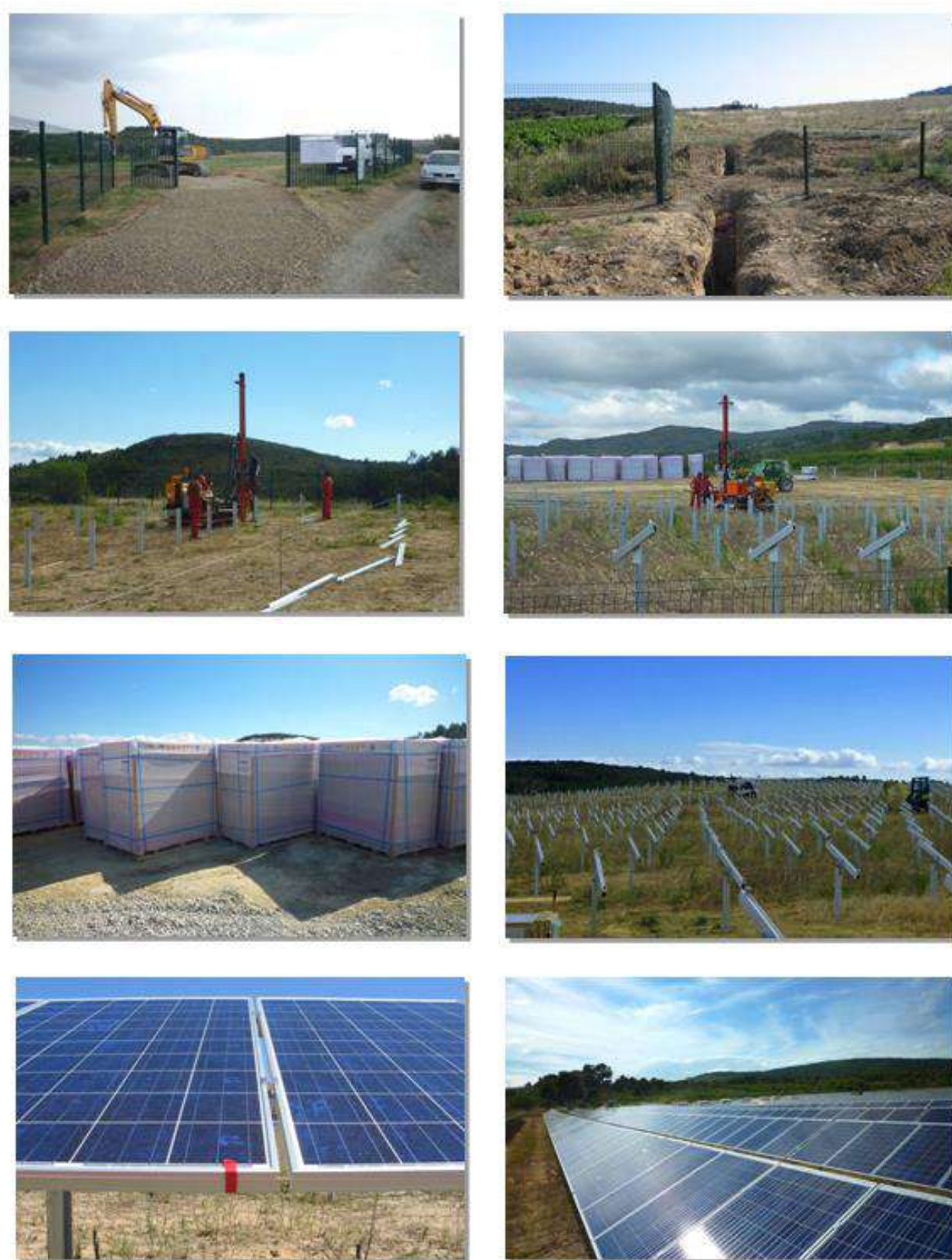
Figure 32 : Présentation des différentes étapes du chantier - Source : LUXEL
