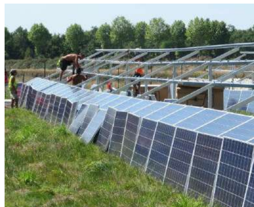
Figure 78 : Pose manuelle des modules
