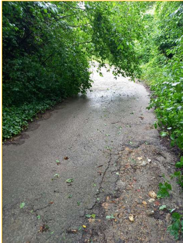
Figure 18 : Voie desservant l'aire d'étude
