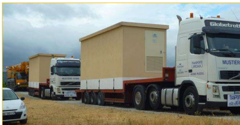
Figure 24 : Transport des locaux techniques
